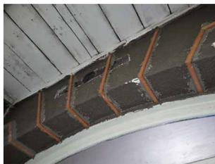
柱や土台の腐食は思った以上に激しかったが、慎重にそして丁寧に行われた補強工事により、十分な強度を得た。また、過去に付け加えられた部材を撤去したことで、内外とも建設当時の塗装色が現れ、建具などの色についても根拠のある再生となった。
